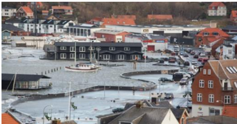
Figur 4.5: Eksempel på højvandsmur. Øverst: Højvandsmur i Lemvig. Nederst: højvandsmur bestående af mur og glasvæg Kilde: Vejledning om kystbeskyttelsesmetoder, Kystdirektoratet 2018
