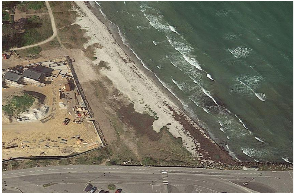
Figur 5.2: Strækning umiddelbart nord for molen i færgehavnen, hvor der er udført en betonmur foran den opførte bebyggelse. På forsiden af betonmuren er udført en stenskråningsbeskyttelse
